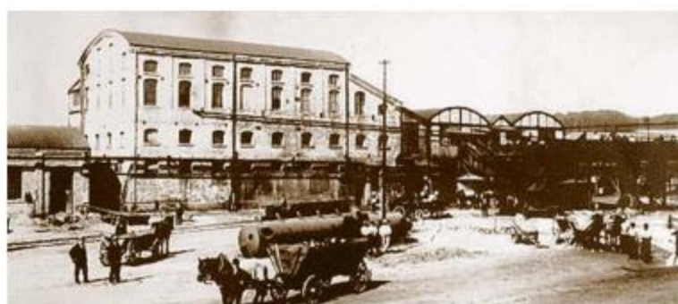
Der Kohlenversandplatz der Rischbach-Anlage mit der neuen Kohlenwäsche, errichtet etwa 1897.
