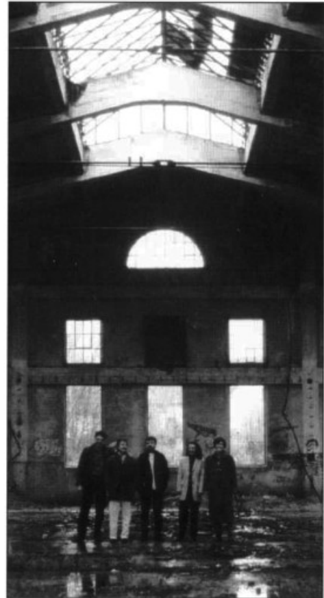
Abb. 80: Barbaratag 1994, ehem. Maschinenhalle der Grube Frankenholz
