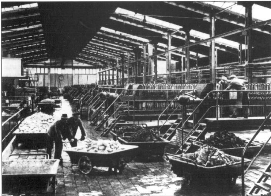
Abb. 5/6: Filterpressenbühne 1921 und 1938 - die Druckausübung durch Handbetätigung mittels Zahnradübersetzung entfällt
