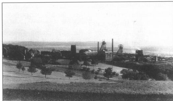
Überblick über die Schächte I und II: Noch zu Lebzeiten des Grubengründers wurden die beiden Schächte abgeteuf. Bis 1890 wurden 218.000 Tonnen Kohle gefördert.
