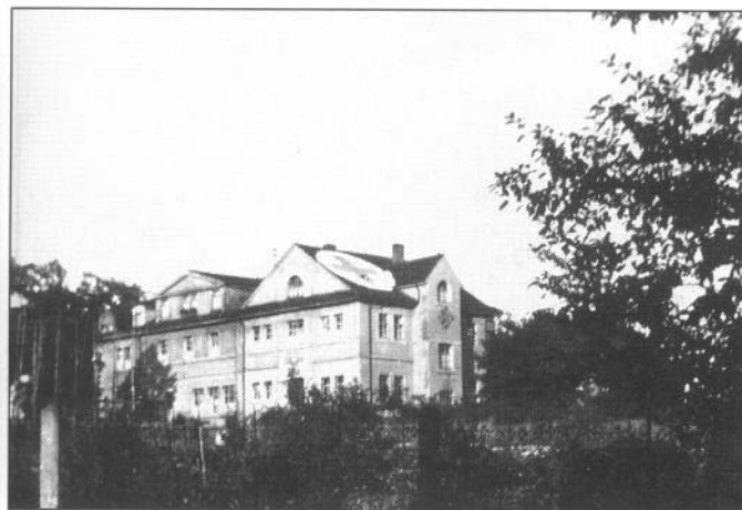
1896 als Grubenlazarett in Dienst gestellt, 1976 geschlossen und abgerissen, überdauerte das Frankenhölzer Krankenhaus das Bergwerk mehr als zwei Jahrzehnte.
