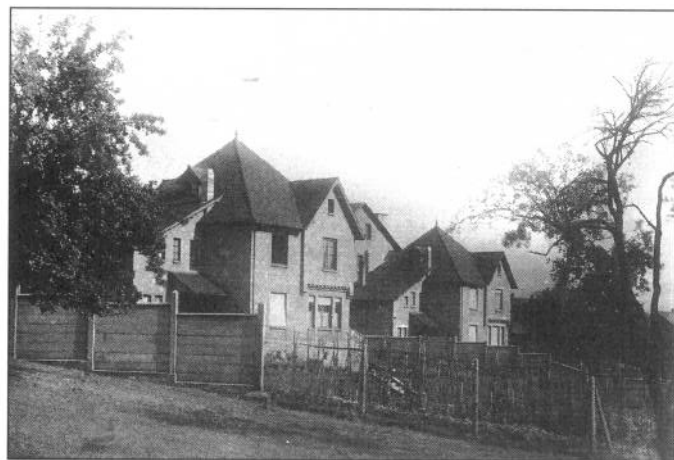
Zwei stattliche Wohngebäude für leitende Grubenbeamte wurden, in identischer Bauweise, während der Völkerbundszeit errichtet.
