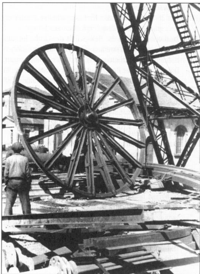
Das Aus für die Grube kam 1954. Dann begann die Demontage der Tagesanlagen; als erstes wurden die Fördererüste abgebaut.
