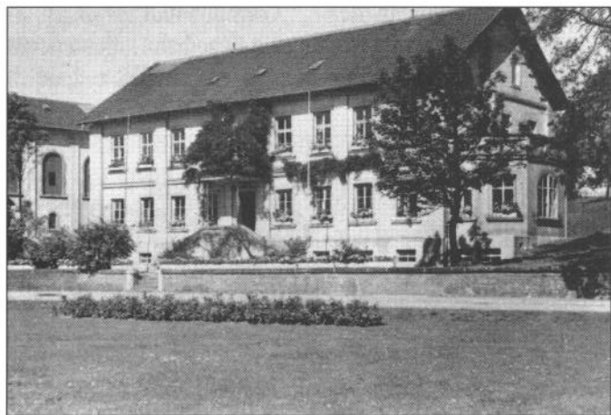
Das Verwaltungsgebäude befand sich direkt auf dem Gelände von Schacht I und II. Der stattliche Bau wurde im Zuge der Demontage nach 1959 abgerissen.
