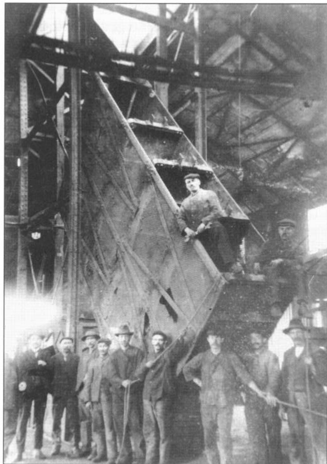
Über vieretägige Förderkörbe wurde auf Schacht III ab 1900 Kohle gefördert. Für Frankenholz hatte damit ein neues technisches Zeitalter begonnen.
